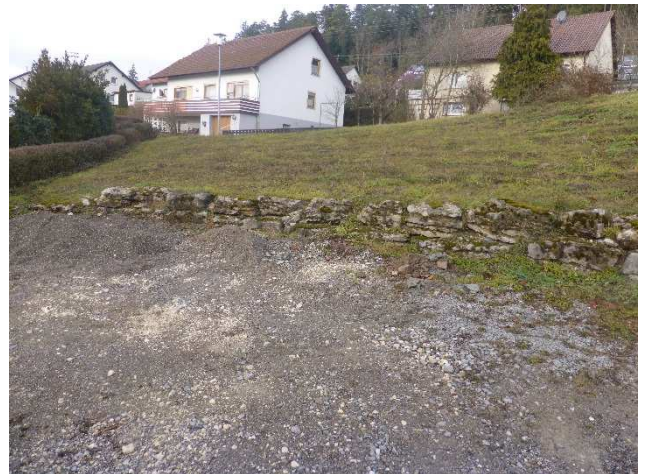
Foto 2: Schotterfläche mit Natursteinmauer und angrenzender Mähwiese
