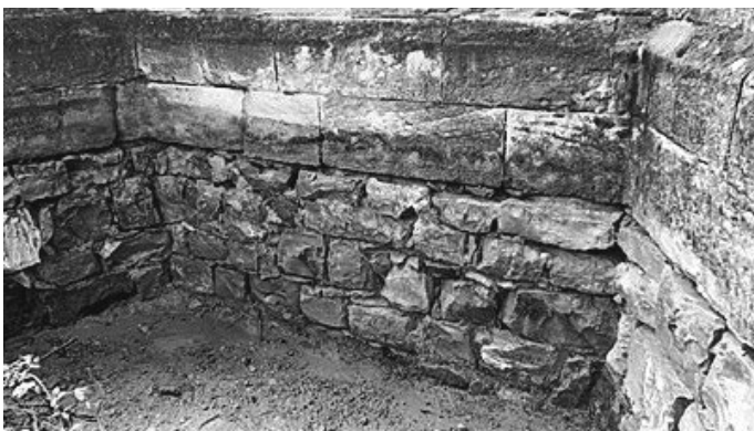
Mit Hochdruckreiniger gesäuberte Grundmauer
