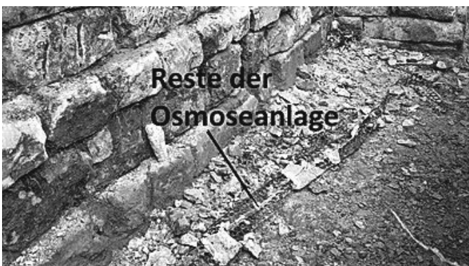
Reste der Osmoseanlage
