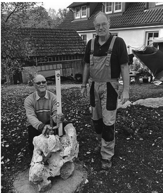
Sockel des Kreuzes wurde einbetoniert
