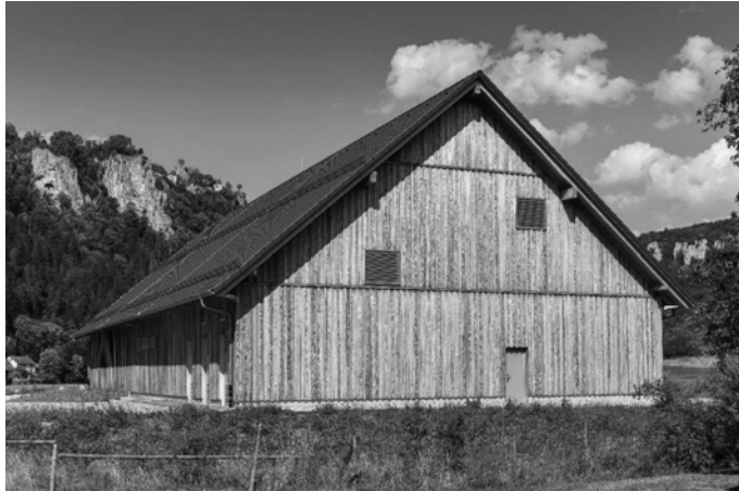
Wie ein riesiger Schuppen kommt das Wasserwerk Langenbrunn daher, drinnen beherbergt es aber modernste Technik. Fotos: Stadt Meßstetten/Volker Bitzer
